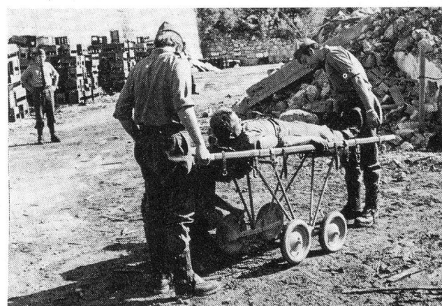
Das ist der Prototyp einer neuen Rollbahre, vor allem für den Zivilschutz, deren Räder «selbstdenkend» beim Transport über Trümmer den Verletzten schonen und seine Handhabung erleichtern
