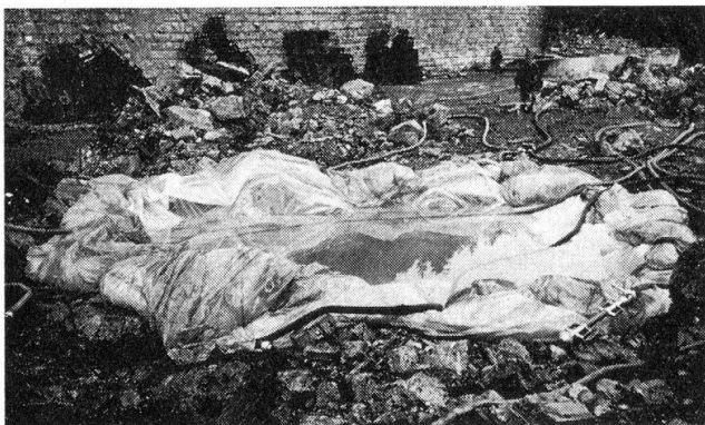
Mit Plastictüchern inmitten von Trümmern improvisiertes Löschwasserbecken
