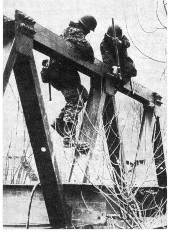
Zu den Traditionstruppen der Bundeswehr gehören die Pioniere, die hier eine D-Brücke (Dreieckträger-Brücke ) einbauen, eine Entwicklung der Firma Krupp
