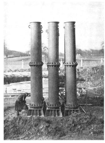
Abb. 3. Beispiel für die schachbrettartige Anordnung von Wasserkanonen.
