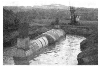
Abb. 2. Schalenbauwerk von rund 14 m Länge auf einer Rutsche montiert, in die wassergefüllte Baugrube gezogen, durch Füllen mit Wasser versenkt, Eindecken mit Aushubmaterial und Auspumpen des Wassers aus dem Bauwerk.
