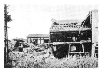
Abb. 9. Hiroshima: Wirkung auf Holzbauten 3500 Meter vom Nullpunkt entfernt
