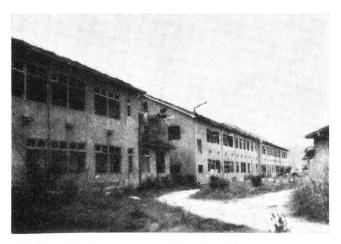
Abb. 8. Hiroshima: leichte Schäden, 3 km vom Nullpunkt entfernt
