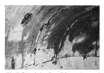
Abb. 13. Zustand einer 7 cm dicken armierten und gebogenen Wand einer Betonschale nach der Explosion einer 50-kg-Bombe in 4 m Abstand auf der Tiefe der Sohle
