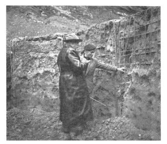
Abb. 2. Durch Bombensplitter erodierte Betonwände
