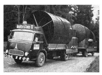
Abb. 17. Transport der Blechzylinder für die Elemente eines 6 m langen Schutzraumes mit einem 7 m langen Vorraum und Abzweiger
