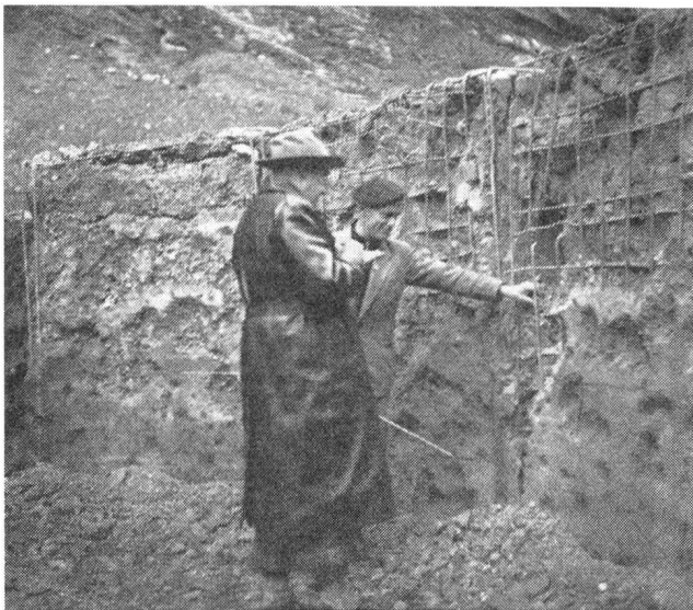
Abb. 2. Durch Bombensplitter erodierte Betonwände
