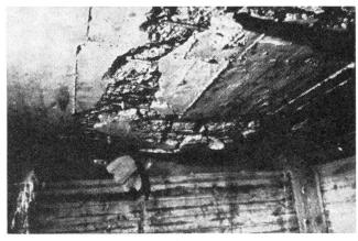
Abb. 5. Durch Fallasten entstandene Absprengung auf der Unterseite einer Betondecke
