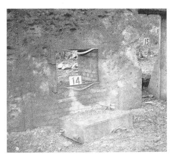
Abb. 3. Durch die Wirkung von Bombensplittern auf die Scharnierrollen abgefallener Panzerbetondeckel
