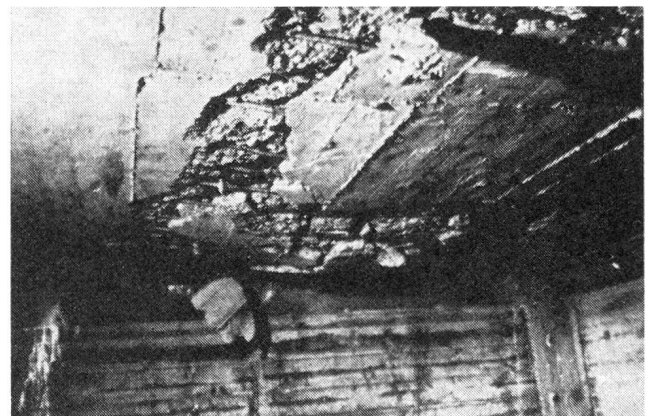
Abb. 5. Durch Fallasten entstandene Absprengung auf der Unterseite einer Betondecke
