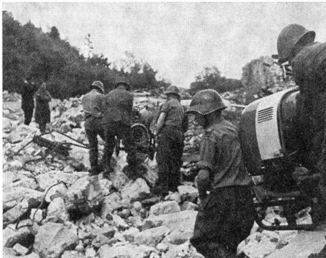
Abb. 14b Transport des zerlegten Kompressors über Trümmer; man beachte die offene Kupplung; Trennstelle
