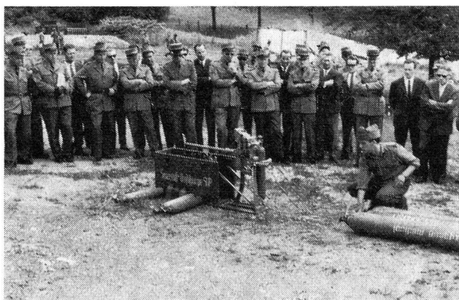
Abb. 4a. Sauerstoff-Handumfüllpumpe: Ueberströmen des Sauerstoffes aus der grossen Vorratsflasche in die Geräteflasche
