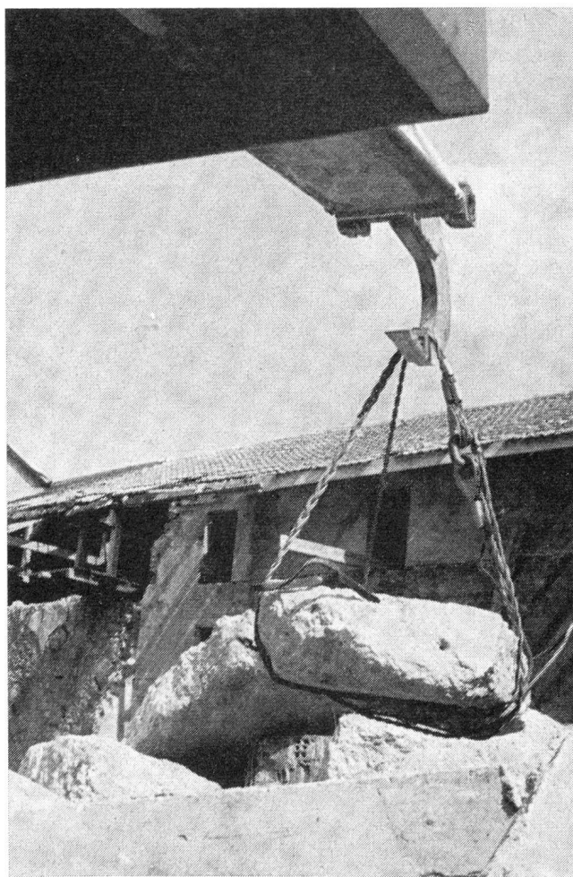
Abb. 3c. Verwendung der Drahtseilstrippen beim Herausheben eines Trümmerbrockens mittels Greifhaken des Teleskop-Baggers
