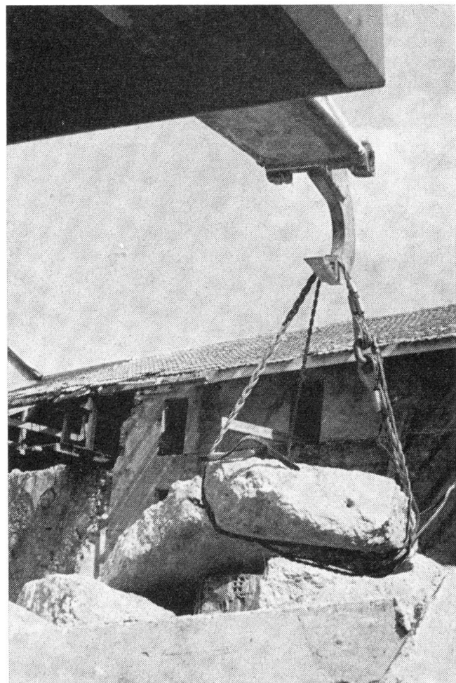
Abb. 3c. Verwendung der Drahtseilstripfen beim Herausheben eines Trümmerbrockens mittels Greifhaken des Teleskop-Baggers
