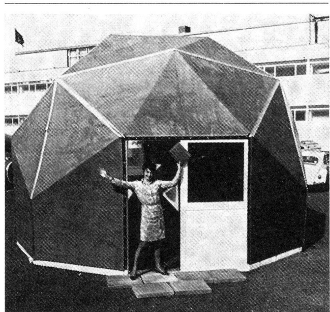
«Nicht von Pappe»... sind diese Wellpapphäuser. Das verspricht jedenfalls der Konstrukteur der ungewöhnlichen Heime. Serienmässig verpackt können ungelernete Kräfte ihr Ferienheim in wenigen Stunden aufstellen. Ein weiterer Verwendungszweck ist der Einsatz der «Papierhäuser» als erste Bleibe von Katastrophengeschädigten (Ky.)
