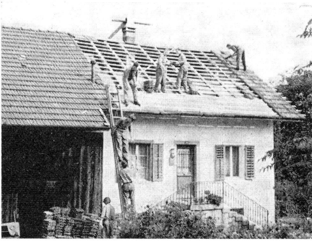
Neueindecken einer Dachfläche
