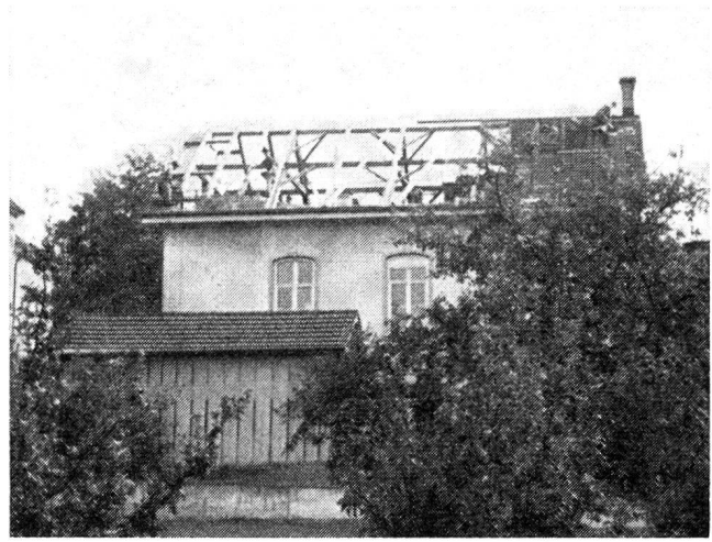
Hier wurde der gesamte Dachstuhl erneuert
