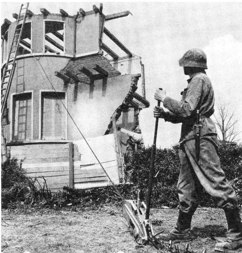
Die vielseitigen Aufgaben im Zivilschutz-, Luftschutz- und Geniedienst erfordern ein kombiniertes Zug- und Hebegerät, welches schnell an schwierigste Einsatzstellen getragen und unabhängig von motorischen Kraftquellen durch jedermann bedient werden kann.
