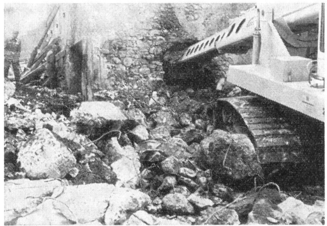
Arbeit durch Mauerluke hindurch im Innern des Gebäudes: Einführen des Werkzeuges.
