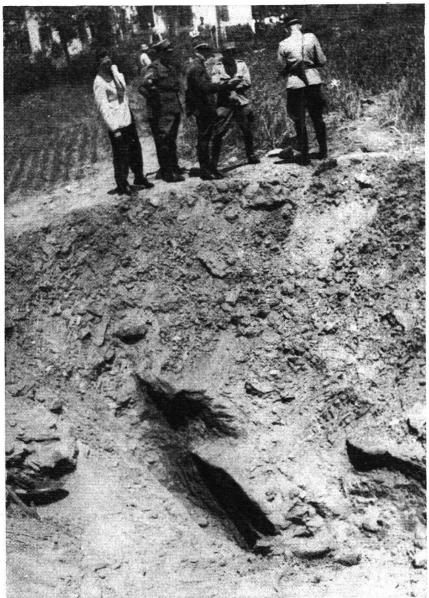
Einschlagstelle ca. 50 m südlich des Hauses Alte Rüm-langstrasse 43, Zürich-Seebach, Sprengwirkung, Trichter von ca. 8 m Durchmesser und ca. 2,3 m Tiefe (Sandsteinfels).
