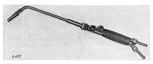
Abb. 3. Schweissbrenner mit auswechselbarem Einsatz.
