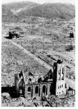
Abb. 20. Japanische Aufnahme des gleichen Quartiers in Hiroshima vor und nach der Explosion; der Vordergrund befindet sich in zirka 800 m Abstand vom Schadenzentrum, welches sich hinten links vom Bildrand befindet.
