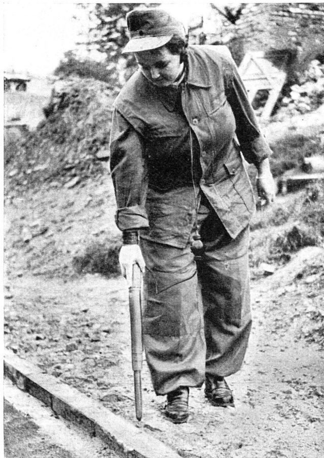
Die Arbeit mit dem Geigerzähler gehört zur praktischen In- struktion dieser Kurse. Dieses Modell gibt akustische Signale, während andere mit Zeigerausschlag optisch reagieren.
