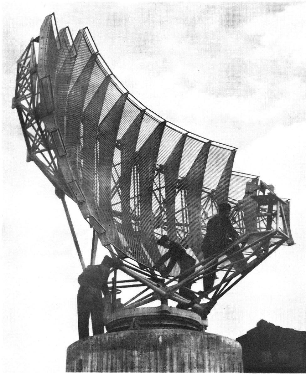
Angehörige der ersten schweizerischen RADAR-RS bei der Bedienung einer Radar-Einfach-Antenne für Jagdflieger-Leitung
