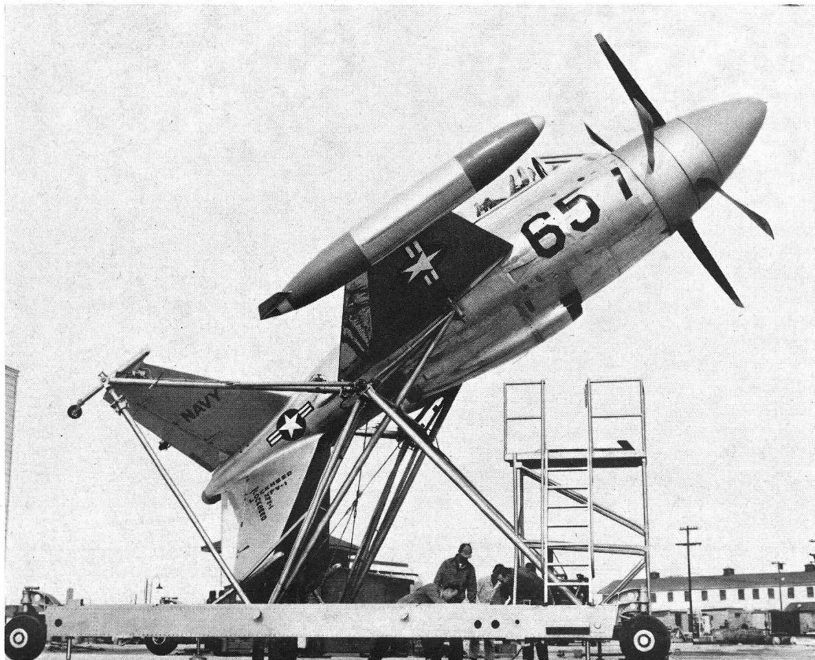
auf dem von Lockheed eigens konstruierten Transportwagen, auf dem das TURBOPROPELLER-kampfflugzeug in vertikale Stellung zum Senkrecht-Start gebracht werden kann.
