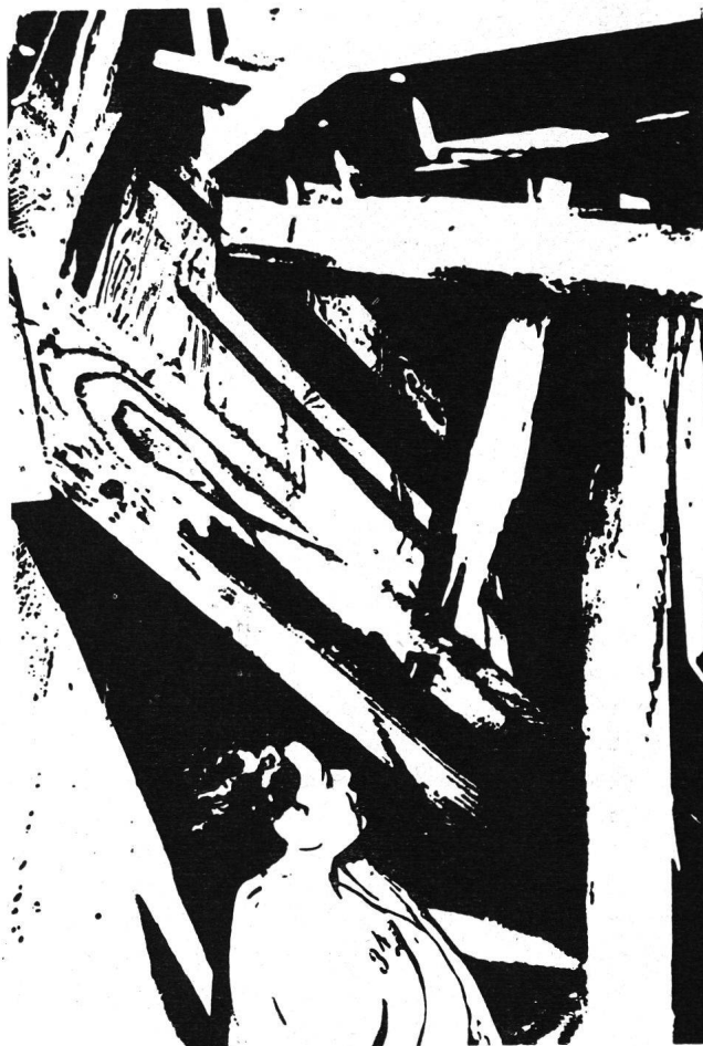
Abb. 5: Schrägdach-Unterschlupf im Keller des nächstgelegenen Versuchshauses, 1,07 km vom Nullpunkt entfernt. Das Haus darüber ist vollständig zerstört, ein Teil davon in den Keller hinuntergestürzt. Die Puppen im Unterschlupf blieben jedoch unbeeinträchtigt.
