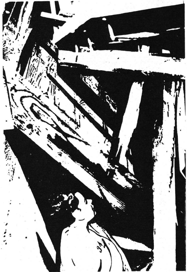
Abb. 5: Schrägdach-Unterschlupf im Keller des nächstgelegenen Versuchshauses, 1,07 km vom Nullpunkt entfernt. Das Haus darüber ist vollständig zerstört, ein Teil davon in den Keller hinuntergestürzt. Die Puppen im Unterschlupf blieben jedoch unbeeinträchtigt.
