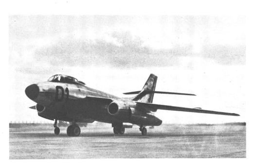
(Das Flugzeug besitzt zwecks Verkürzung seiner Landestrecke den sogenannten Brems-Fallschirm. Die Besatzung verfügt über eine Druckkabine mit Panzerung und Schleudersitz-Aggregat)
