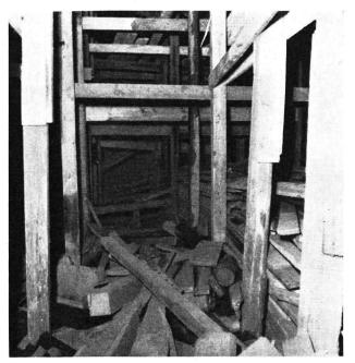
In Verbindung mit den Luftschutzräumen im Urgestein unter Abelhaugen werden Verbindungskorridore zu den Osloer Untergrundbahnen erstellt. Unser Bild zeigt einen dieser Gänge in Arbeit.
