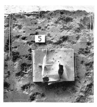
Mit Eisenblech verschalter Eisenbetondeckel. Splitterwirkung nach der ersten 500-kg-Bombe. Die Splitter schlugen nicht durch und der Deckel konnte weiterhin geschlossen und geöffnet werden.
