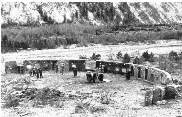
Die Versuchsanlage nach der ersten Sprengung einer 500-kg-Bombe.
