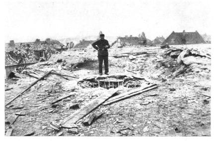
Abb. 6. Essen, Luftschutzhochbunker, Baujahr 1943, Wandstärke 1,10 m, Deckenstärke 1,40 m. Spiralbewehrung mit zusätzlichen statischen Betonstählen in der Zugzone. Bombengewicht 2000—3000 kg. Die Decke zeigt oben ein rundes Loch von etwa 2,60 m ∅. An der Unterseite der Decke ist das Loch bis 4,00 m gross. 21 Gefallene und etwa 100 Verwundete.
