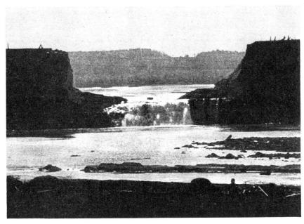
Abb. 4. Möhnetalsperre nach Zerstörung der Sperrmauer am 16. Mai 1943. (Fassungsvermögen 135 Millionen m³.)
