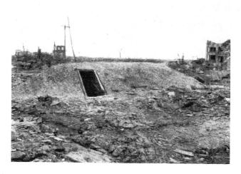
Primitiver Schutzraum in Hiroshima, nur 300 m vom Schadenzentrum entfernt. Der Schutzraum erlitt keinen Schaden. Ob die X-Strahlen durch die Erde absorbiert wurden oder nicht, konnte nicht ermittelt werden. Infolge der ungünstigen Druckfortpflanzung bei Nahtreffern von Brisanzbomben haben wir in der Schweiz solche Konstruktionen in den letzten Jahren abgelehnt.
