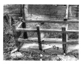
Wirkung der Hitzestrahlung in Nagasaki. Oberflächlich versengtes Holzgestell mit deutlicher Abzeichnung des «Schattens» der senkrechten Pfosten. Es war den Japanern möglich, aus mehreren solchen Objekten die Lage und Höhe der Explosion zu bestimmen. Als Abstand des hier abgebildeten Gestells wird ca. 1,2 km genannt. Die Gerade A—C kann ungefähr als ½ so lang als A—B angenommen werden, woraus sich ergibt, dass die Explosionshöhe ca. 600 m betrug.
