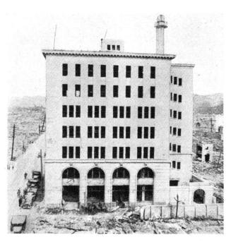
Eisenbetongebäude mit auch in den Wänden durchgehender Armierung, nur 300 m vom Schadenzentrum in Hiroshima entfernt. Man beachte auch die schiefgedrückten Telephon- und Fahnenstangen. In den untern Stockwerken hatte die Strahlung keinen Einfluss auf die Gesundheit der Insassen.
