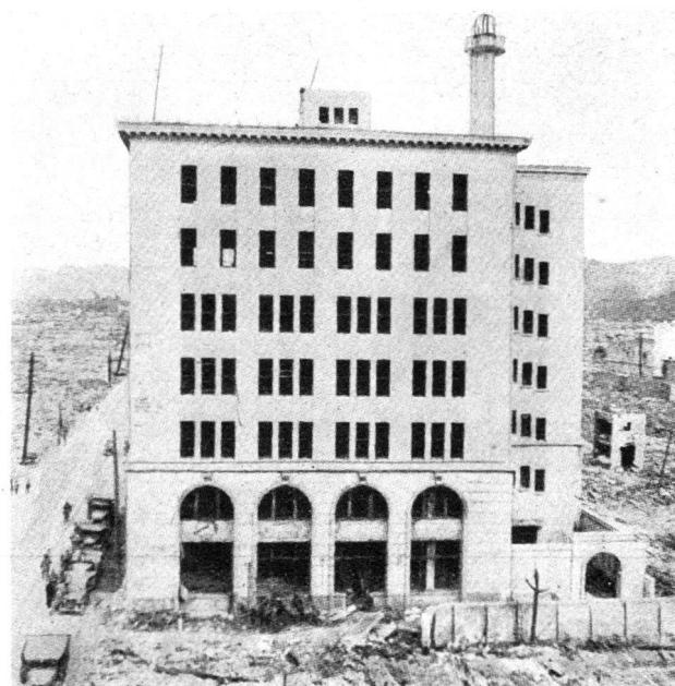
Eisenbetongebäude mit auch in den Wänden durchgehender Armierung, nur 300 m vom Schadenzentrum in Hiroshima entfernt. Man beachte auch die schiefgedrückten Telephon- und Fahnensäulen. In den unteren Stockwerken hatte die Strahlung keinen Einfluss auf die Gesundheit der Insassen.
