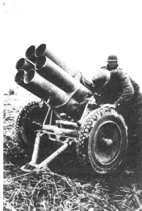
Deutscher 15-cm-Raketenwerfer mit sechs Rohren auf Fahrgestell.
