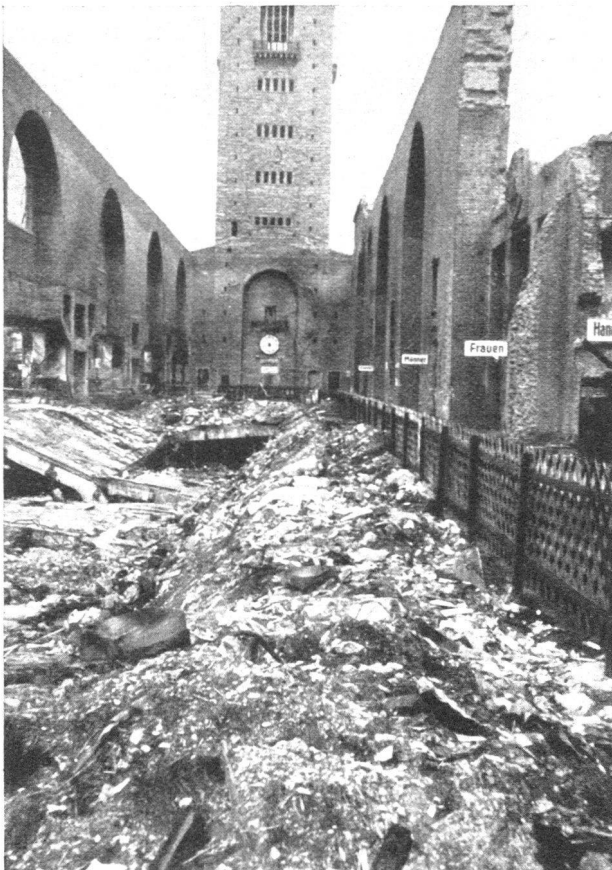
Stuttgart, Hauptbahnhof (grosse Halle)
