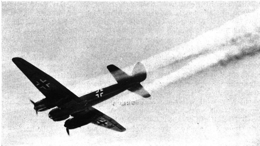
Langsam und hauchdünn beginnt bei der Ju 88 die Bildung der Kondensstreifen in Höhe des Leitwerkes. Immer mehr verdichten sich die Streifen, bis schliesslich eine dicke Nebelwolke entsteht.
