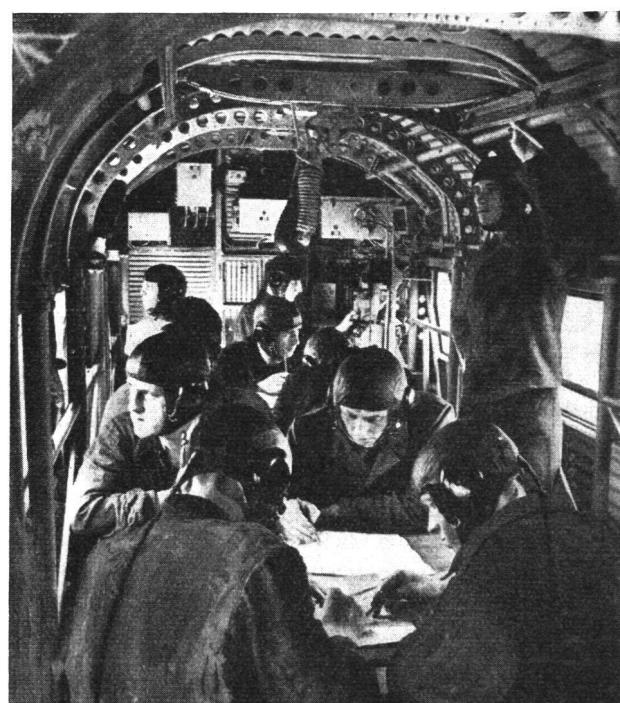
Blick in den Kabinenraum eines Ju-52-Hörsaalflugzeugs. Der «Fliegende Theoriesaal» gestattet während des Fluges den praktischen Unterricht über alle flieg- rischen, navigatorischen und funktechnischen Fragen und zeigt wesentliche, erfolgsichere Vorteile gegenüber allen theoretischen Lehrmethoden.
