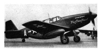
Mustang-Langstreckenjäger, gekennzeichnet durch die beiden unter den Flügeln angebrachten, abwerfbaren Zusatzbrennstofftanks für Bomberbegleitschutz über grosse Anflugstrecken.
