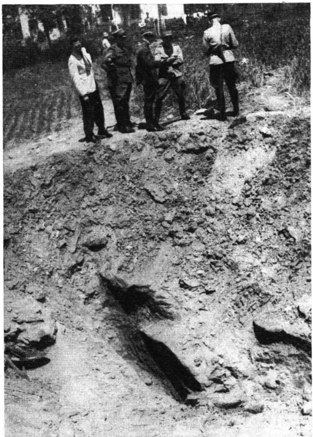
Einschlagstelle ca. 50 m südlich des Hauses Alte Rüm-langstrasse 43, Zürich-Seebach, Sprengwirkung, Trichter von ca. 8 m Durchmesser und ca. 2,3 m Tiefe (Sandsteinfels).
