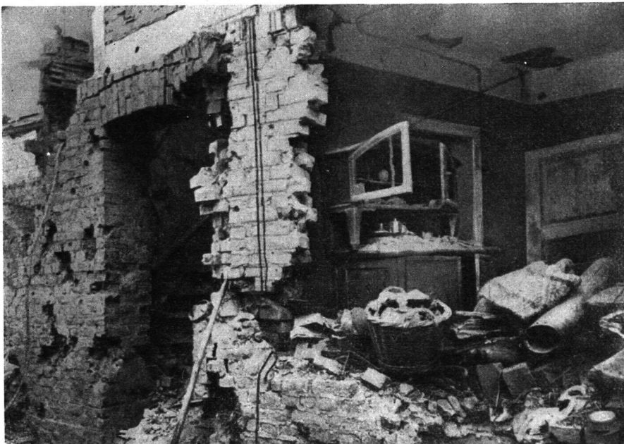
Abb. 13. Wirkung von Luftstoss, Sog und Splitterwirkung eines Nahtreffers auf ein Gebäude aus Backsteinmauerwerk. Der Luftstoss hat Fensterepfeiler und Brüstung eingedrückt. Das Mauerwerk wurde durch die Splitterwirkung «ausgewaschen» und zerrissen. Die Backsteine zerbrachen und lösten sich vom Mörtel. Der Verband der innern Quermauer mit der Fassadenmauer rechts vom Hauseingang ist aufgegrissen. Diese Verbindung wird meist nicht mit der nötigen Sorgfalt gemauert. Der Sog hat am Buffet Türen geöffnet und den Buffetaufbau gegen den Explosionsherd hin verschoben. Unter der Einwirkung des Soges hat sich auch der Deckenputz von der Zimmerdecke gelöst.
