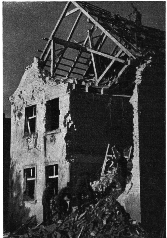
Abb. 19. Sekundäre Trümmerwirkung eines Gebäudes aus Backsteinmauerwerk infolge eines Naktreffers. Vermutlich genügte die Zerstörung eines Fensterpfeilers in der jetzigen Lücke, um die eine Hälfte des Giebels zum Einsturz zu bringen. Der Schuttkegel steigt in einer geraden Linie nach hinten hoch an: Zuoberst im Schuttkegel liegen die Möbel des ersten Stockes. Das Gebälk, das auf der Vorderfassade sein Auflager verloren hat, liegt noch auf der hintern Quermauer auf. Das Dachgebälk rutscht in die Lücke nach und hängt noch an der Nagelung des Dachbodens. Der Dachstuhl ist mangelhaft konstruiert, der Schub des Dachstuhles wird durch das Gebälk nicht aufgenommen, weil es über dem ersten Stock in falscher Richtung läuft.
