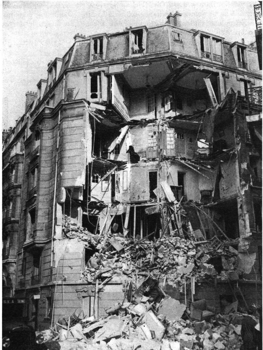
Abb. 12. Halb zerstörtes Haus. Der Rand der Zerstörung zeigt die gleiche birnförmige Linie, wie das Spannungsdiagramm in Abb. 11. Diese Ausbauchung zeichnet sich links und rechts, sowie auch in der Tiefe ab. Fast die ganze Fassade hat es gegen den Sprengherd zugeworfen. In den Trümmern vor dem Haus erkennt man Teile des Dachgesimses. Im Hausinnern liegen nur die Böden und Innenmauern. Der Schuttkegel vor dem Haus ist nur etwa 2 m hoch. Der Sog hat alle Türen gegen den Explosionsherd hin geöffnet.
