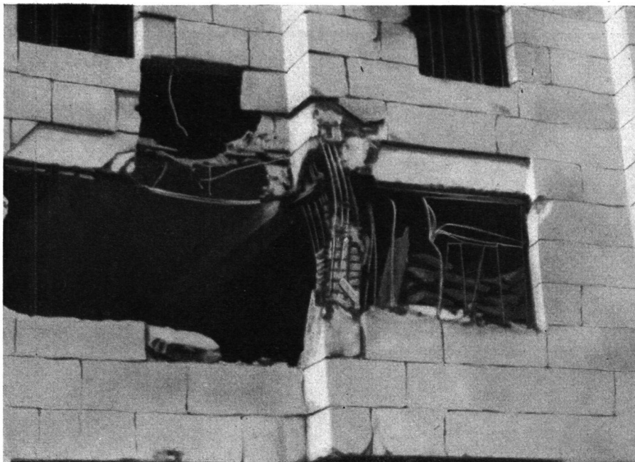
Abb. 7. Durch Explosionswirkung verformte Eisenbetonstütze. Zuerst wird der Schutzbeton völlig zerstört, dann erfolgt die Verformung der Eisen, dann wird der Betonkern zerstört, der vielfach die Verformung des Eisens hindert. Man erkennt hier, dass eine Spiralarmierung beste Wirkung ausgeübt hätte. Dank der Kontinuität aller Tragteile stürzt das Haus nicht ein.
