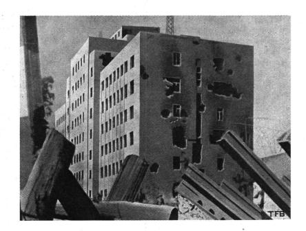
Abb. 9. Wirkung von Volltreffern auf einen massiven Eisenbetonbau.
