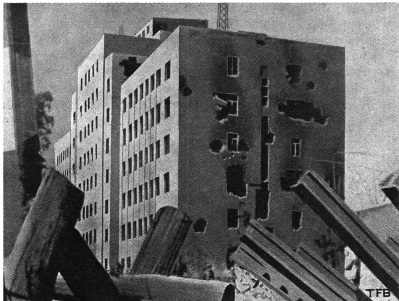
Abb. 9. Wirkung von Volltreffern auf einen massiven Eisenbetonbau.
