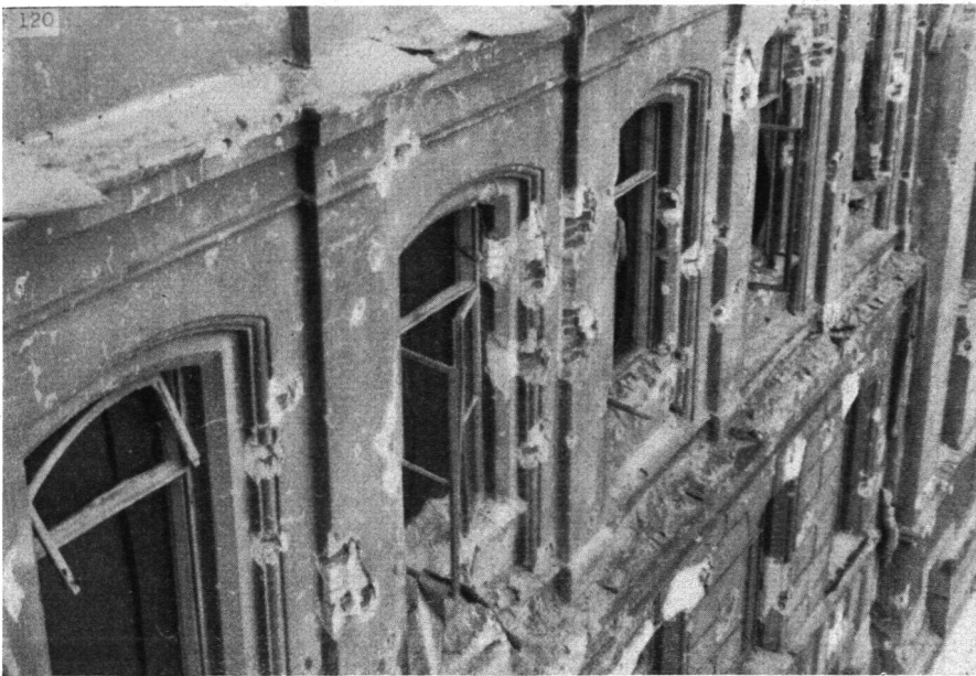
Abb. 5. Unter Splitterwirkung «ausgewaschene» Fassade.
