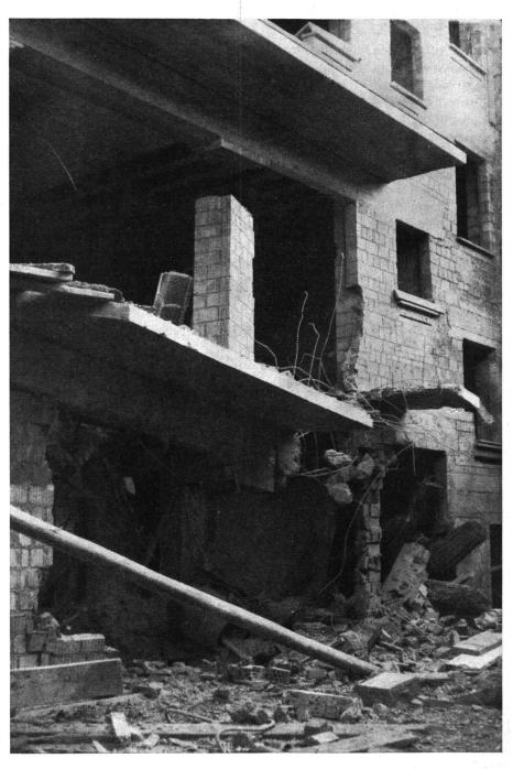
Abb. 8. Wirkung des Explosivdruckes auf einen Eisenbetonunterzug. Eine 50-kg-Bombe detonierte links hinter dem Unterzug. Der Eisenbetonträger zerriss nicht am Ort der grössten
