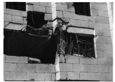
Abb. 7. Durch Explosionswirkung verformte Eisenbetonstütze. Zuerst wird der Schutzbeton völlig zerstört, dann erfolgt die Verformung der Eisen, dann wird der Betonkern zerstört, der vielfach die Verformung des Eisens hindert. Man erkennt hier, dass eine Spiralarmierung beste Wirkung ausgeübt hätte. Dank der Kontinuität aller Tragteile stürzt das Haus nicht ein.
