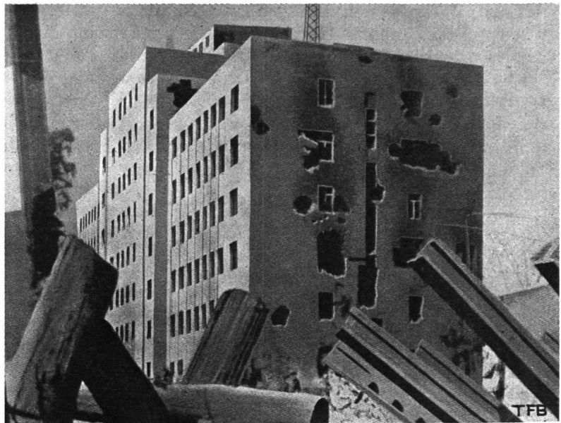
Abb. 9. Wirkung von Volltreffern auf einen massiven Eisenbetonbau.
