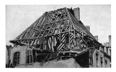
Abb. 2. Explosion einer Bombe im Dachstock. Wirkung auf Massivbau und Skelett: Alles, was grosse Oberfläche besass, wurde weggeschleudert: Die Backsteinmauern des Kniestokkes und des obersten Vollgeschosses, die Dachhaut. Alles, was fest skelettartig miteinander verbunden war und kleine Oberfläche hat, blieb nahezu unversehrt stehen: Der hölzerne Dachstuhl samt Sparren und Latten.
