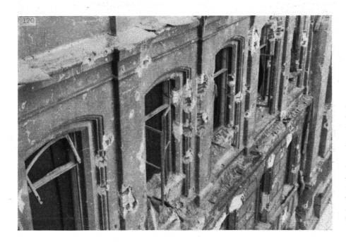
Abb. 5. Unter Splitterwirkung «ausgewaschene» Fassade.
