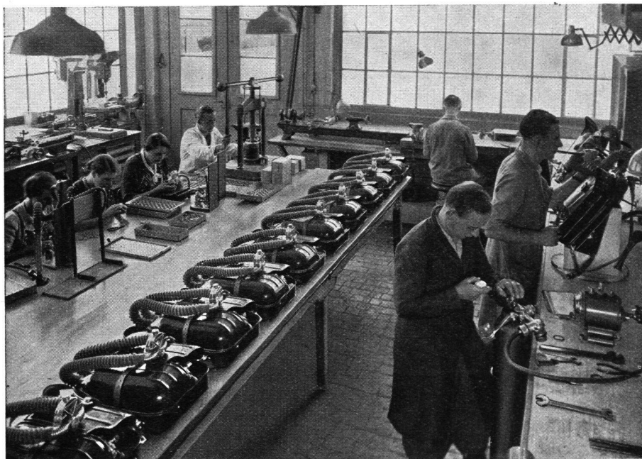
Abb. 2 FEGA-Fabrikation des Sauerstoff-Schutzgerätes Type KG 130 A
