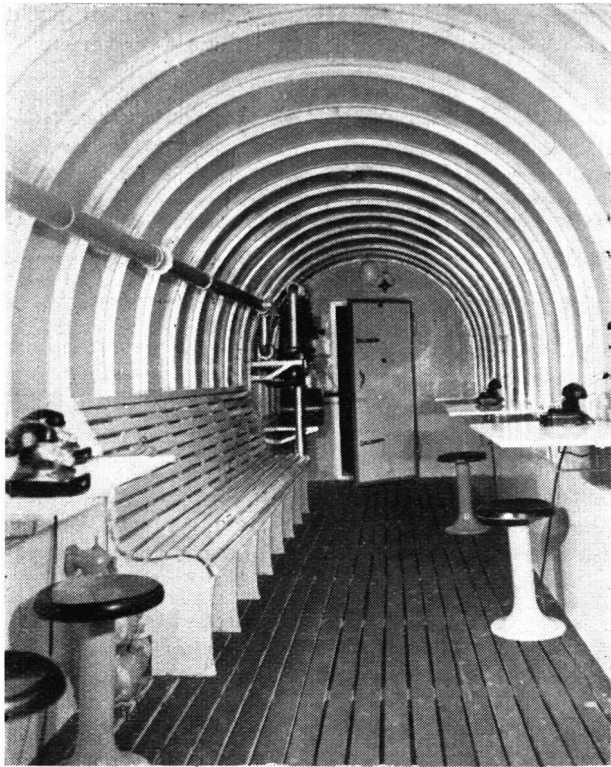
Innenansicht eines Schutzraumes, welcher als Befehlsstand einer Luftschutztruppe dient. — Hinten links: Filter mit Raumbelüftungsanlage.
