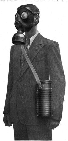
kann. Beim Ausatmen wird dieses Ventil automatisch geschlossen, sodass die ausgeatmete Luft nicht mehr durch den Filter streichen kann.
