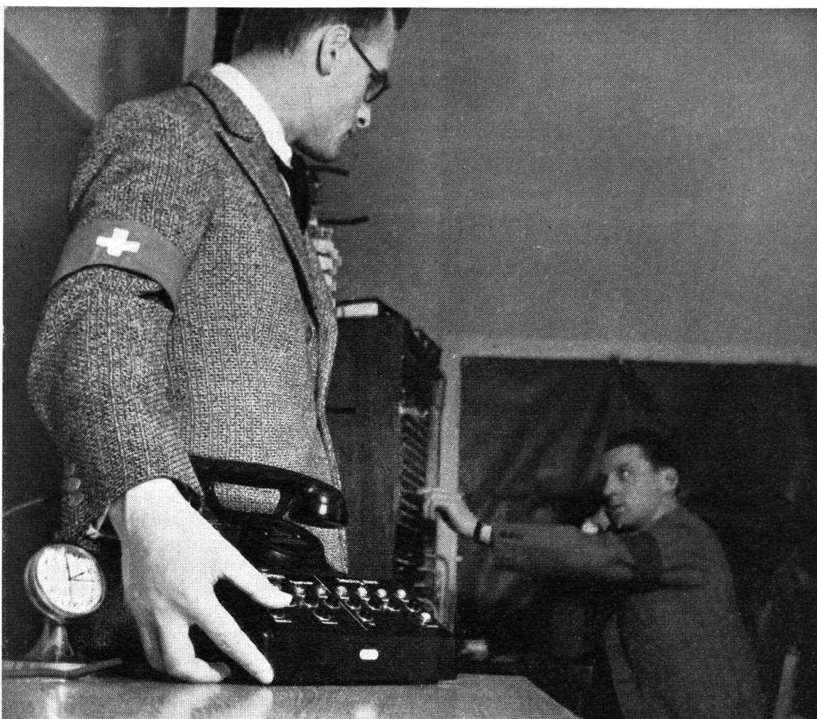
Die Alarmstation: Um den „Fliegeralarm“ für eine ganze Stadt auszulösen, genügt der Druck auf einen kleinen Knopf und augenblicklich heulen die elektrisch ferngesteuerten Sirenen auf.
