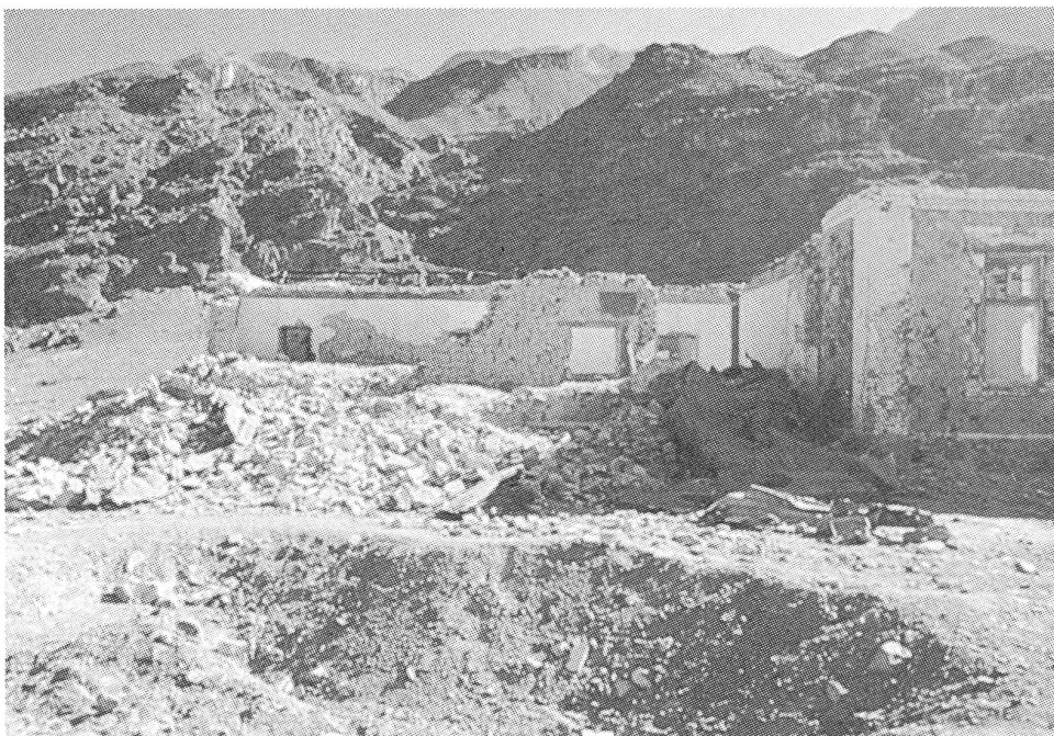
Das Spital in Doab nach seiner Zerstörung durch eine gezielte Bombardierung am 28. 5. 1984.
