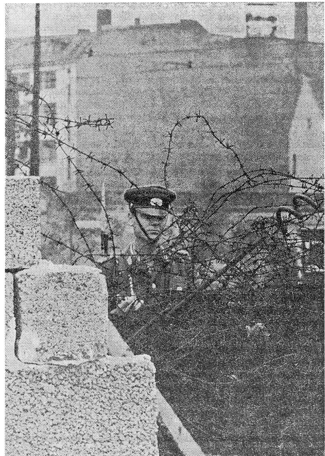
Zementziegel, Betonplatten und Stacheldraht entlang der Sektorengrenze in Ostberlin. Dahinter die Posten der «Volksarmee». An dieser Stelle gelang es zwei Ostberlinern, mit einem Lastwagen die Mauer zu durchbrechen und nach dem Westen zu flüchten. Die Aufnahme entstand zwei Tage darnach.
