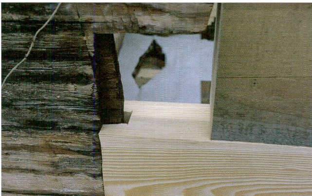
Abb. 7 Detail des Anschlusses einer Ergänzung an das Original an Wand A.
