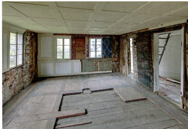
Abb.36 Haus Gütschweg 11. Westanbau (Raum 1.7). Blick gegen Nordwesten. Süd- und Westwand mit unterschiedlichen Makulaturen, Nordwand (Mitte) mit Blockwand, um 1662 dendrodatiert.
