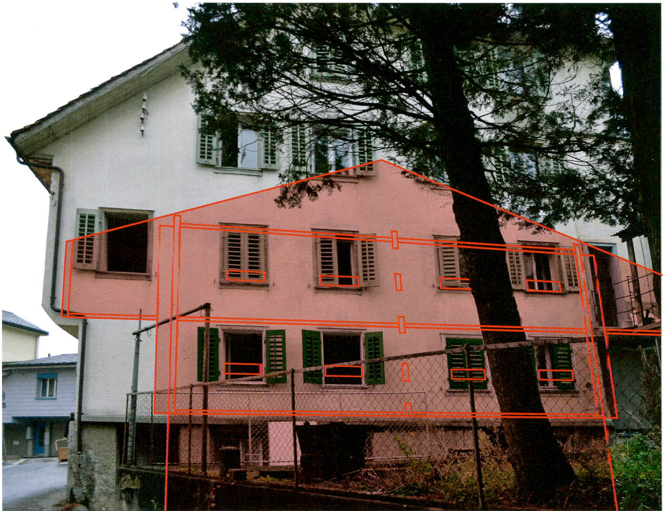
Abb. 15 Haus Dorfbachstrasse 8, Ostfassade mit rekonstruierter Lage des Kernbaus (rot).
