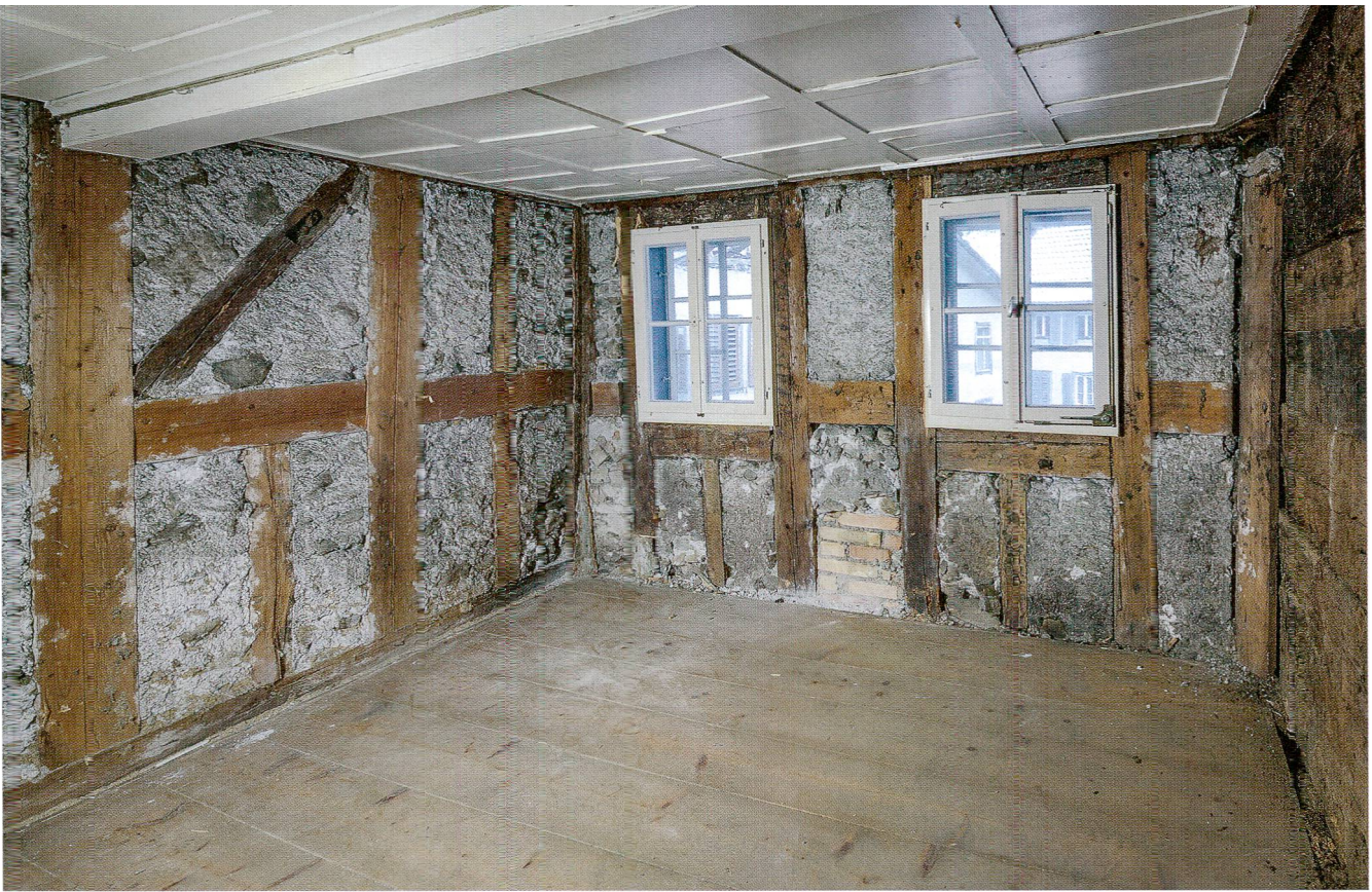
Abb. 39 Haus Gütschweg 11. Nordostanbau (R. 2.11). Blick gegen Nordosten. Riegelbau mit Mauerwerksausfachung.
