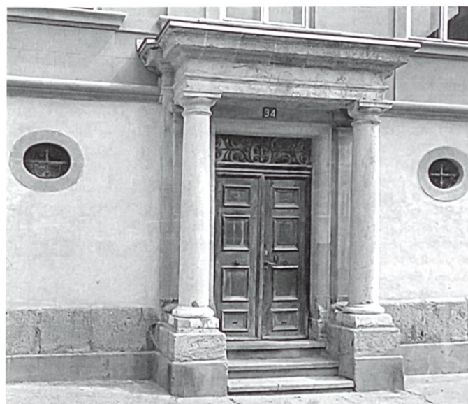
Fig. 4 Moudon, maison Loys de Villardin. Porte d'entrée principale.
