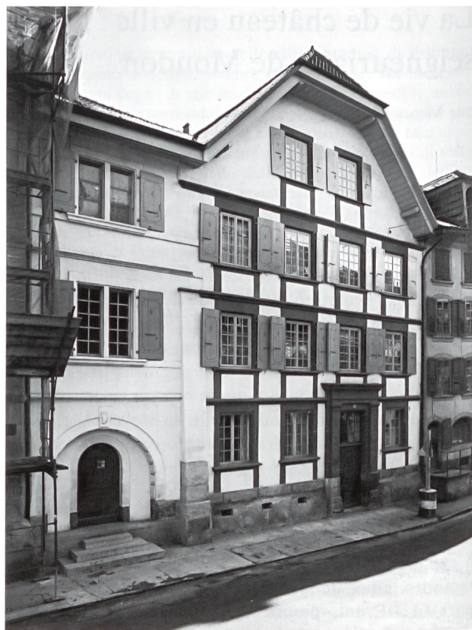
Fig. 2 Moudon, maison construite en 1696 pour le lieutenant du vidomne, le notaire Gabriel Bize.
