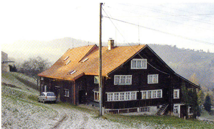
Abb.43 Haus Egger in Unterwolfhalden vor dem Abriss.
