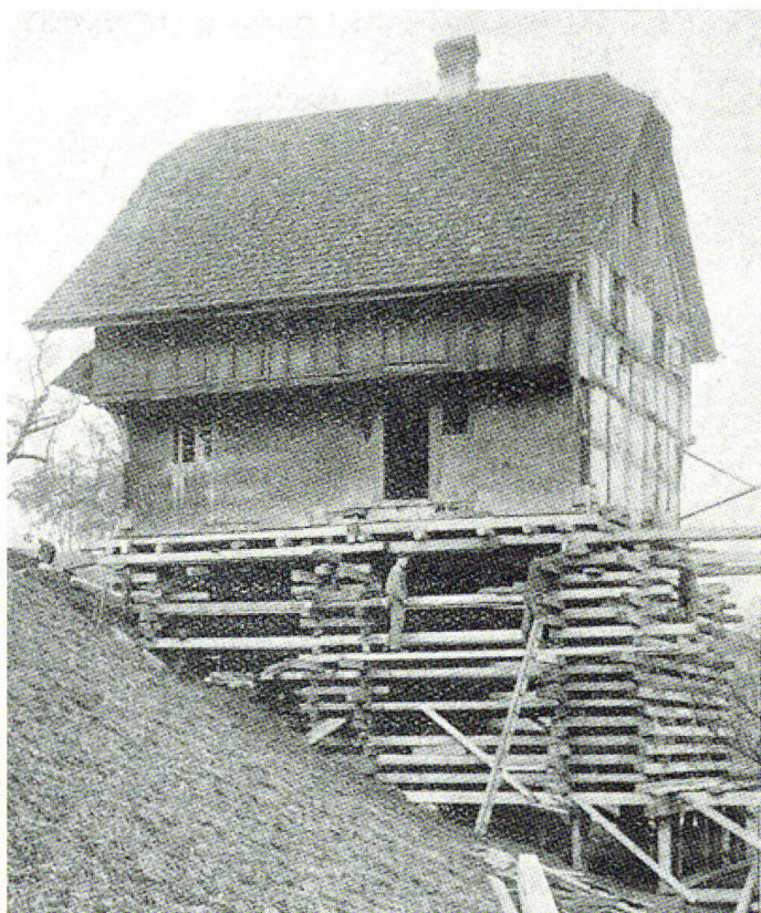
Abb.16 Ein Bauernhaus auf dem Reussbühl bei Emmenbrücke (Luzern) während der Verschiebung, um 1928.
