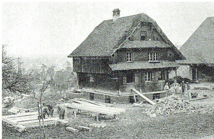
Abb.17 Das Bauernhaus auf dem Reussbühl nach der Verschiebung auf seinem neuen Sockelgeschoss, um 1928.
