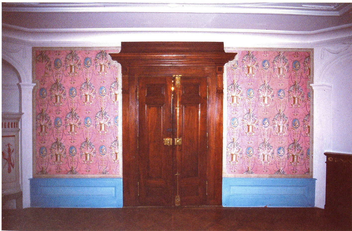
Abb. 4 Wand zur Diele nach Freilegung des Ensembles, 1999, Müllerhaus Lenzburg.
