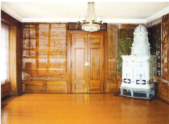
Abb. 16 Die Bretterwand zum westlich des Salons gelegenen Kabinett nach Abnahme des Tapetenensembles, 2006, Neue Burghalde Lenzburg.
