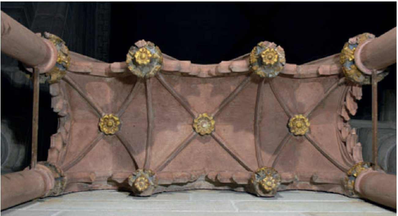
Abb. 15 Blick von unten in die drei Schwebegewölbe des Thronbaldachins.
