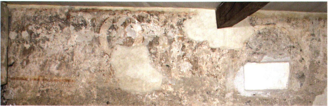
Abb. 4 Ansicht der Südwand des Norpertsaaes im Kloster Münstair.
