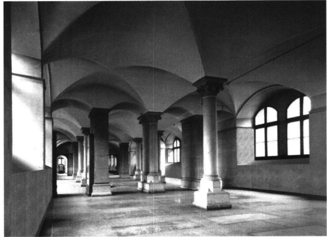
Abb. 7 Bahnhofflügel, Erdgeschoss. Pfeilerstellung noch nicht zugemauert, ein Raumeindruck, der rekonstruiert werden kann.
