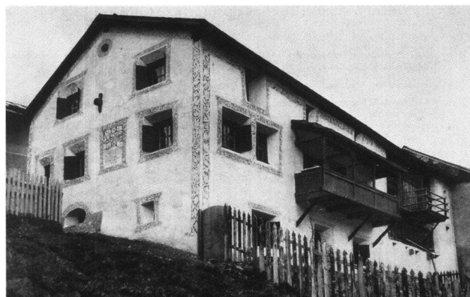
Abb. 7 Haus Stupaun (Haus Nr. 86) in Guarda nach der Renovation.
