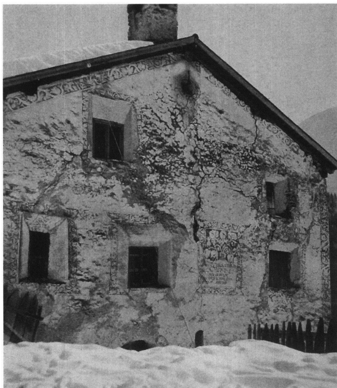
Abb. 6 Haus Stupaun (Haus Nr. 86) in Guarda vor der Renovation.
