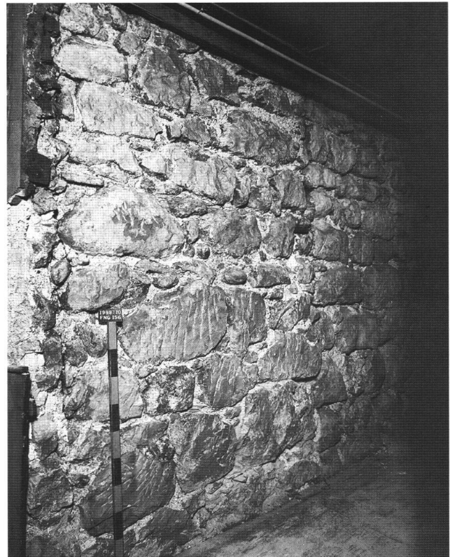
Abb. 15 Ansicht der Stossfuge zwischen dem Steinbau D (rechts) und dem Schalenturm. Zuerst stiess an dieser Stelle der Steinbau D an die Stadtmauer. Diese wurde aber beim Bau des Befestigungsturmes teilweise abgebrochen, damit sie besser mit der Mauer des Turmes verzahnt werden konnte. Deshalb stösst die Innenschale des Turms nun an die Mauerstirne von Steinbau D.
