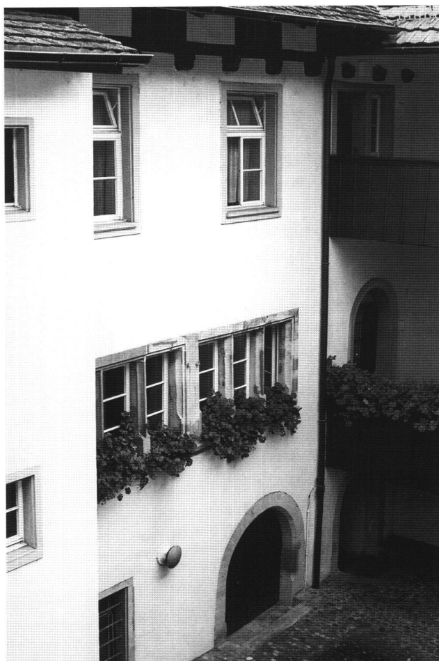
Abb. 20 Ansicht der Hoffassade der Knabenschule. Die Fassade mit dem Rundbogenportal und dem Fensterwagen im ersten Obergeschoss sowie der Laube geht auf den Umbau von 1586/87 zurück.
