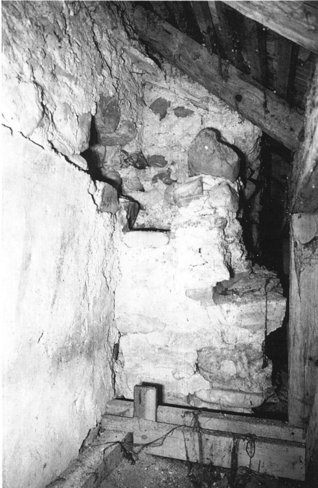
Abb. 19 Situationsansicht der Maueransätze der ehemaligen «Nordquerhaus»-Westmauer (Aufnahme 1980).
