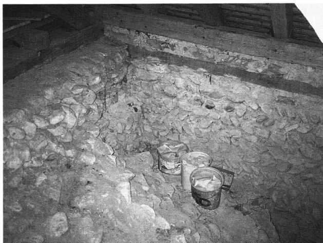
Abb. 36 «Opus spicatum»-artiges Mauerwerk, das die erneuerte Nordmauer der nördlichen Abseite anschliesst (Aufnahme 1993).
