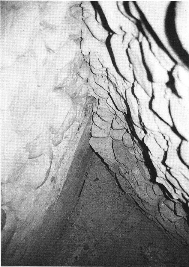
Abb. 38 Nord-Exedra (links im Bild) und nördliche Seitenschiffapsis (Aufnahme 1991).
