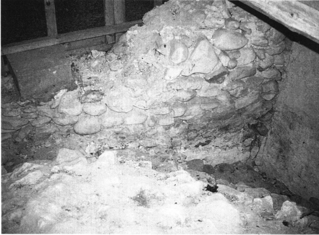
Abb. 21 Nördliche Exedra im Bereich des nördlichen «Querhauses» und Apsiskalotte des nördlichen Seitenschiffs (Aufnahme 1991).
