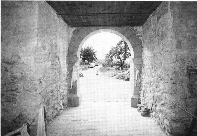
Abb. 45 Blick durch das Erdgeschoss des Portikus nach Westen (Aufnahme 1985).
