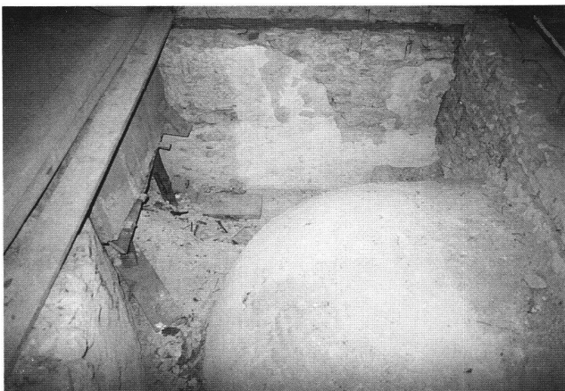
Abb. 13 Dachraum über der südlichen Seitenschiffapside (Aufnahme 1985).
