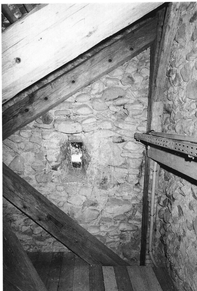
Abb. 31 Nordwesteck des südlichen Dachraumes über der südlichen Abseite (Aufnahme 1985).
