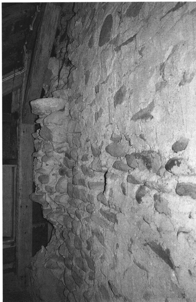
Abb. 20 Dachraum über dem nördlichen Seitenschiff: Nördliche Hochschiffwand des Langhaus-Mittelschiffes und Ansatzstelle (Abbruchrest) der Westmauer des ehemaligen nördlichen «Querhauses» (Aufnahme 1980).
