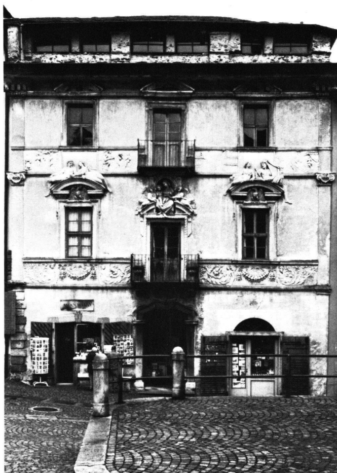
Fig. 1 Ascona, la facciata di casa Serodine.
