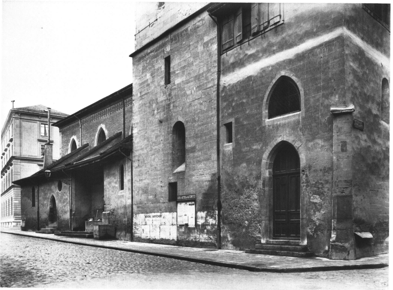
Fig. 2 Eglise Saint-Gervais: sacristie, base du clocher et chapelles méridionales (état avant la restauration de 1902-1906).
